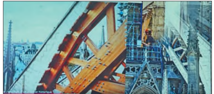
Unterbauung der großen Strebebögen
